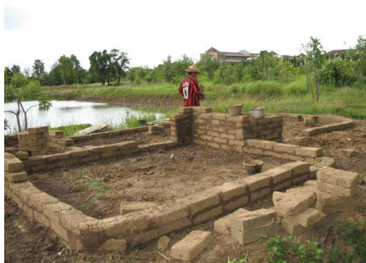
ภาพที่ 5 การก่ออิฐดินดิบ ที่มา : นรินาม, 2554ค.
