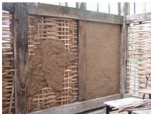
ภาพที่ 7 การปั้นผนังกับโครงไม้
