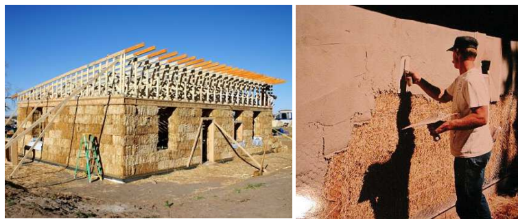
ภาพที่ 12 การก่อสร้างโดยใช้ฟางก่อฉาบด้วยดิน
