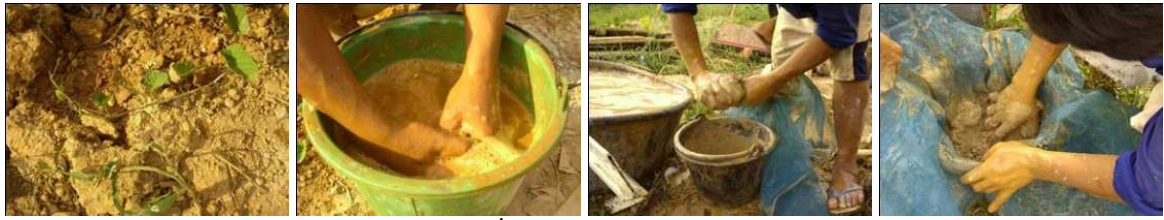
ภาพที่ 14 การผสมสีบ้านดิน ที่มา : สยามบ้านดิน. 2554
