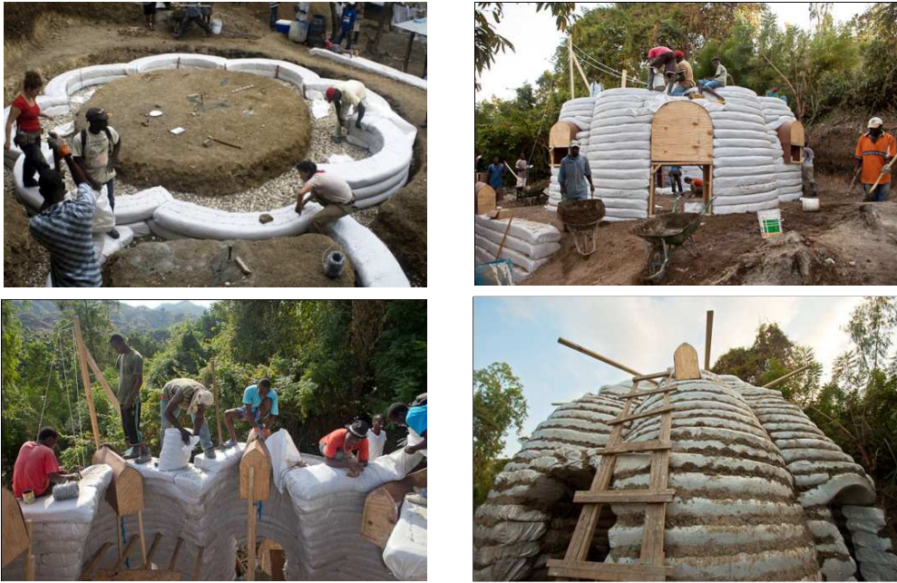
ภาพที่ 10 การก่อสร้างโดยใช้กระสอบ
