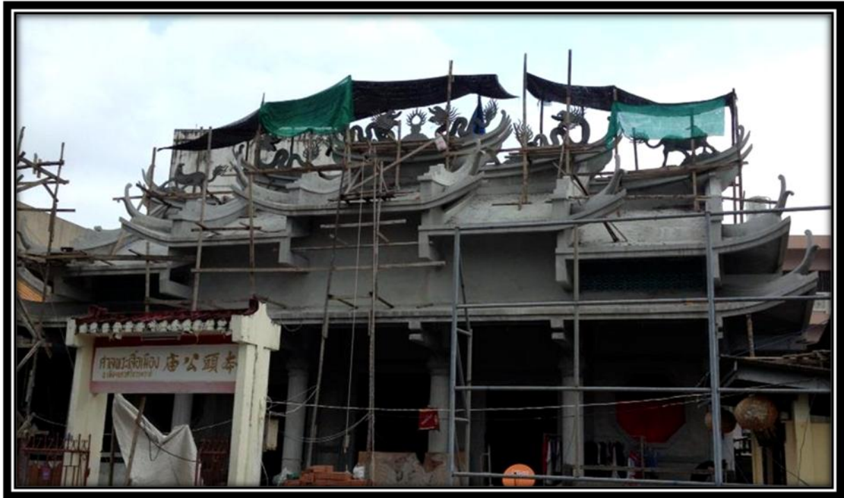
ศาลพระเสื้อเมือง จังหวัดนครศรีธรรมราช ที่กำลังบูรณะ
